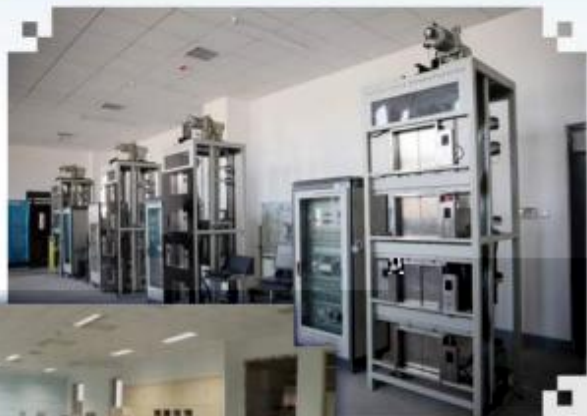
智能电梯安装调试维护训练场所
